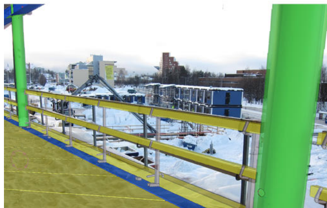
Bild 9. BIM-basierte Planung der Absturzsicherung mit anschließender AR-Visualisierung auf der Baustelle [20] (virtuelles Overlay der Soll- auf die Ist-Situation in Echtzeit)
