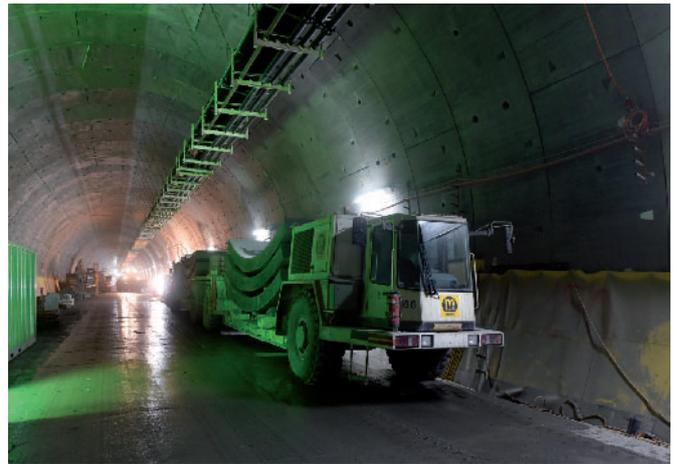
Bild 8. Transportgerät für Tübbinge
