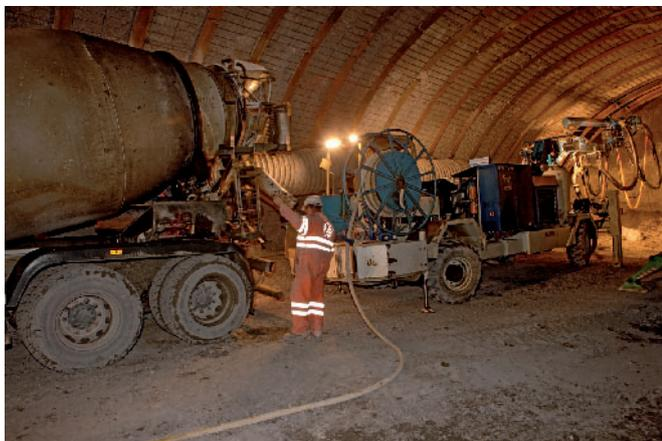
Bild 5. Einweisung eines Betonmischers beim Rückwärtsfahren
